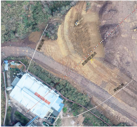
图 6 某滑坡三维模型(正射视角)
