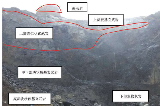
图 2 大方县高店乡白龙村玄武岩矿山采场剖面 (资料来源:贵州省玄武岩分布特征与开发利用方向研究报告,2018年)
