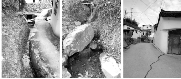
图1 舟溪镇茶林村滑坡体水文地质特征及其滑动变形破坏
