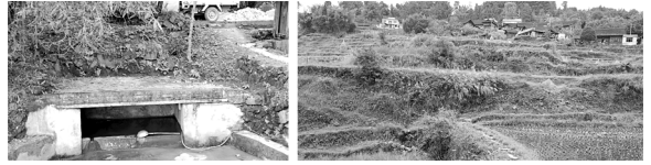
图3 炉山镇新民村滑坡体上变形破坏特征
