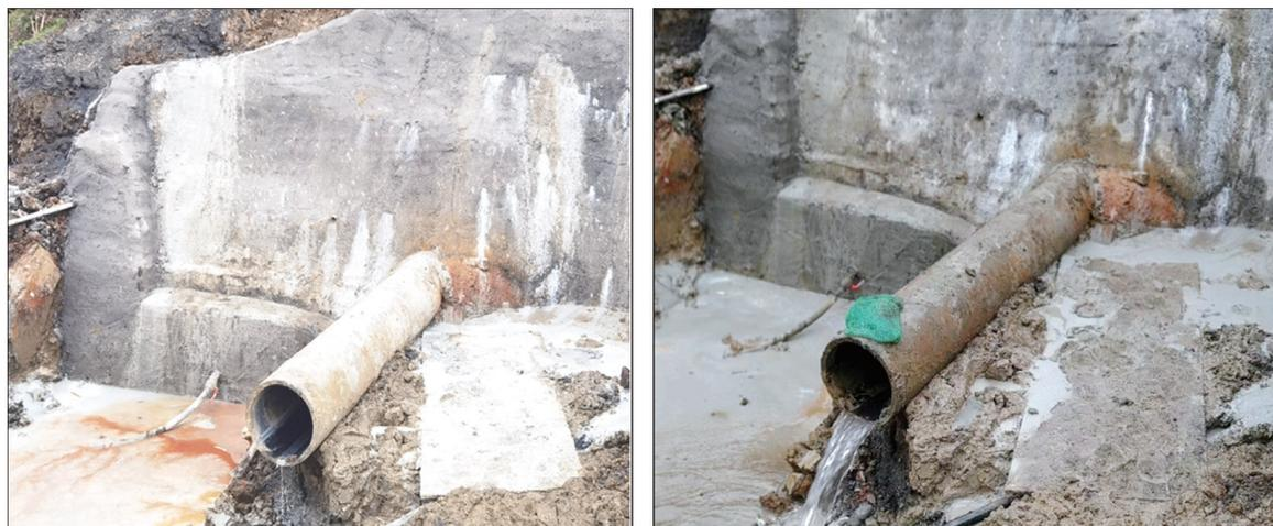
图4 高分子材料注浆前后对比(左为堵水前,右为堵水后)
