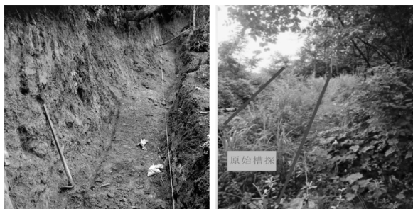
图8 槽探开挖与复垦复绿效果对比图
